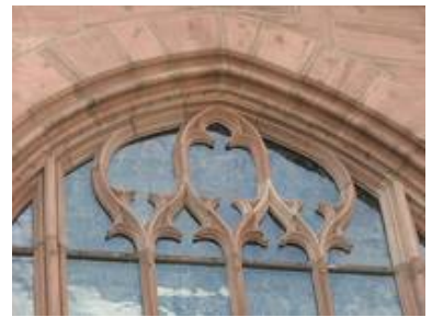
Durch den einschiebigen Aufbau sind auch komplizierte Scheibenformen wie im Maßwerk möglich.
